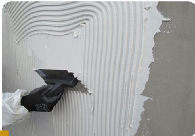
Fot. 1 NAKŁADANIE ZAPRAWY TYNKARSKIEJ PACĄ ZĘBATĄ.
