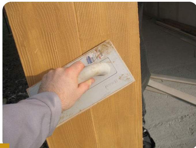
FOT. 6 ZBIERANIE NADMIARU BOLIX DECO LAZUR PRZY POMOCY PACY Z GUMOWYM PODBICIEM
