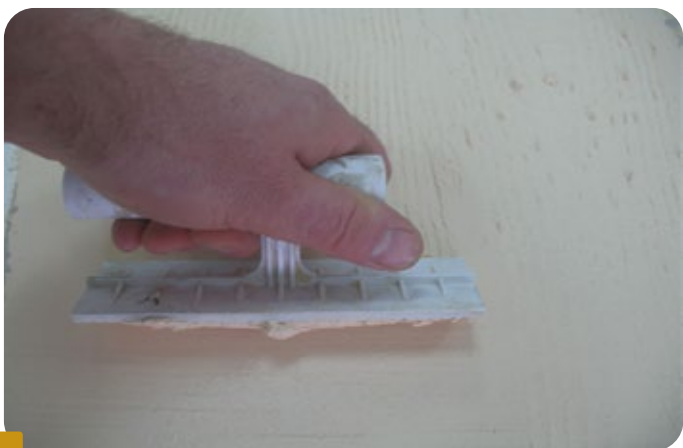
Fot. 3 WYKONANIE STRUKTURY DREWNA W ŚWIEŻYM TYNKU BOLIX TR
