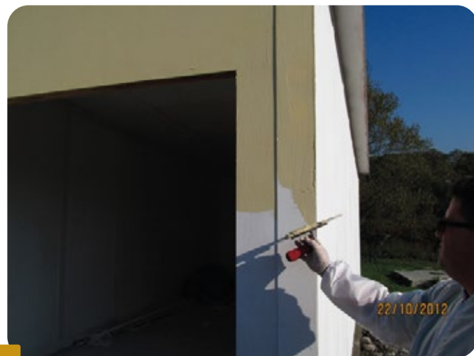
Fot.2 NANOSZENIE BOLIX TR NA ZAGRUNTOWANĄ POWIERZCHNIĘ:
