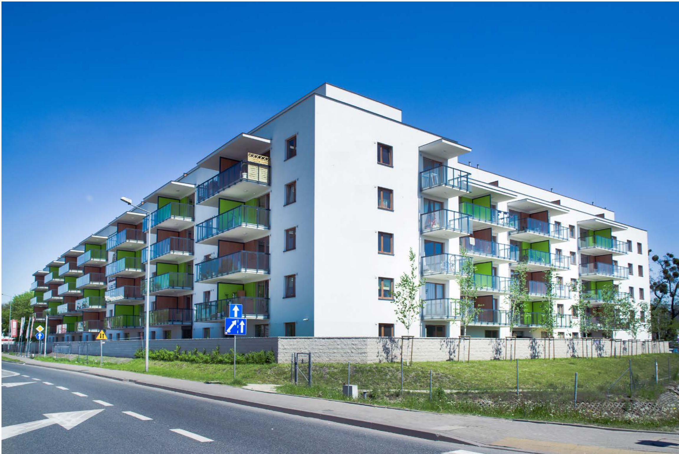
WARSZAWA, UL. DYWIZJONU 303 UNIBEP S.A.
