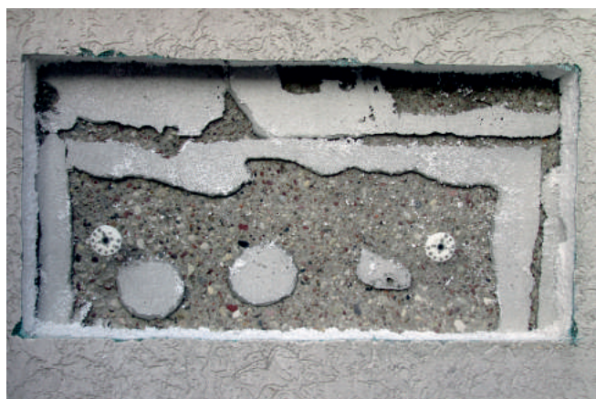
FOT. 1. ISTNIEJĄCE OCIEPLENIE ZAMOCOWANE PRAWIDŁOWO (FOT. ARCHIWUM AUTORA)
