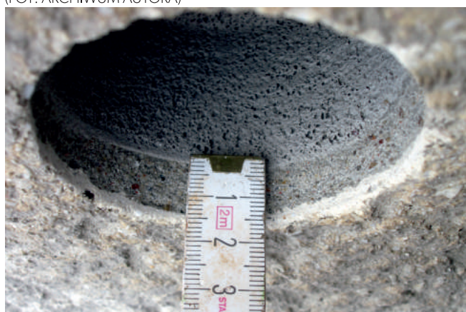
FOT. 7. POMIAR GRUBOŚCI WARSTWY NIEOŚNOŹNYCH ŚCIANY – TYNK ZEWNĘTRZNY (FOT. ARCHIWUM AUTORA)
