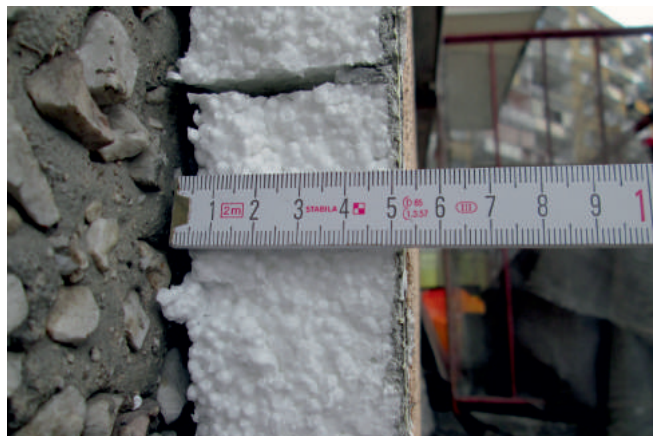
FOT. 5. POMIAR GRUBOŚCI OCIEPLENIA PODCZAS OCENY ODKRYWKOWEJ (FOT. ARCHIWUM AUTORA)
