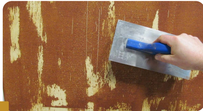
Fot. 2 NAKŁADANIE KOLEJNEJ WARSTWY ZA POMOCĄ PACY NIERDZEWNEJ
