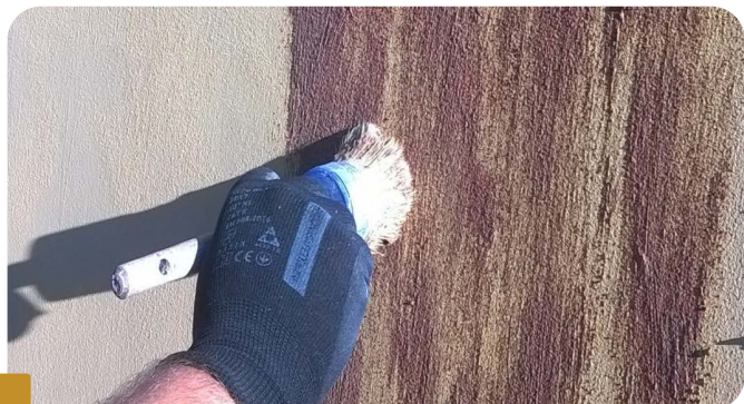
Fot.1 NANOSZENIE TYNKU BOLIX RUST ZA POMOCĄ PĘDZLA TYPU ŁAWKOWIEC
