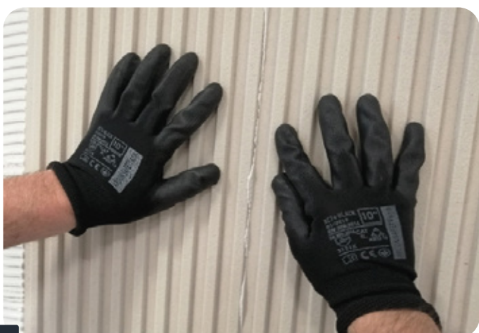
Fot. 4 ŁĄCZENIE PANELI
