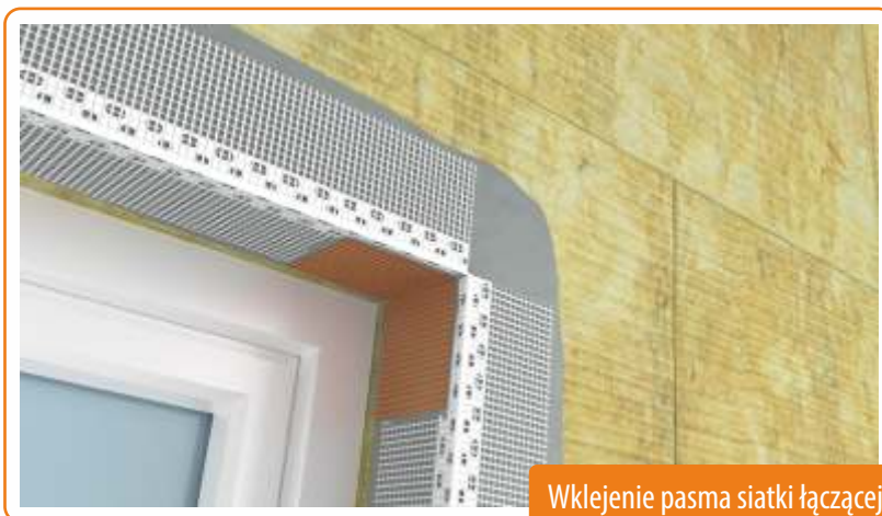
Osadzenie narożników w zaprawie klejącej
