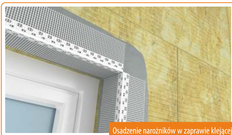
Naniesienie zaprawy klejącej
