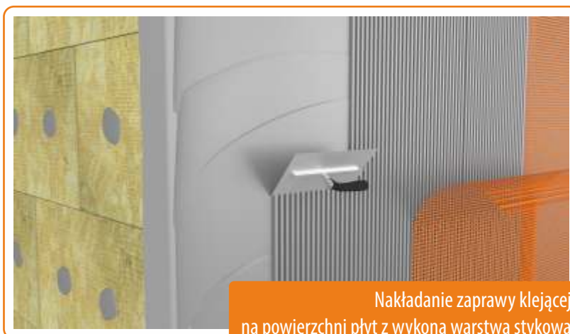
Wykonanie warstwy stykowej
