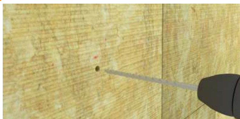
Wywiercenie otworu montażowego. Głębokość kotwienia i średnica wiertła powinny być dobrane indywidualnie do podłoża i rodzaju użytego łącznika mechanicznego
