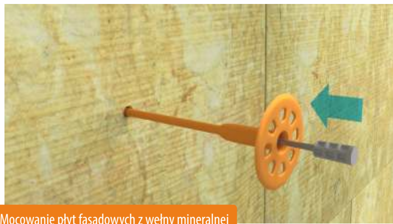
Mocowanie płyt fasadowych z wełny mineralnej
