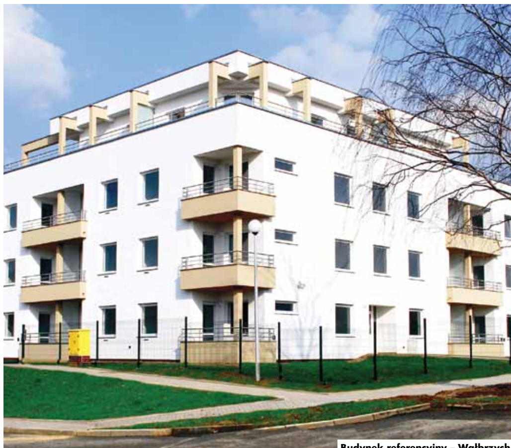
Budynek referencyjny – Wałbrzych.
