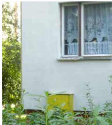
Elewacja pomalowana farbą BOLIX Complex.
