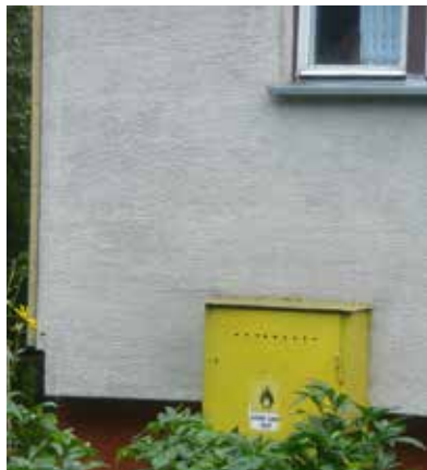
Elewacja umyta środkami BOLIX Complex
