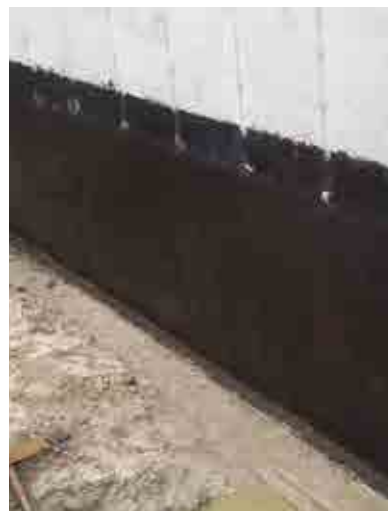
Wykonanie izolacji przeciwwodnej.
