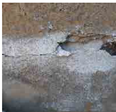
Powstawanie zawilgocenia skutkujące niszczeniem powłok dekoracyjnych
