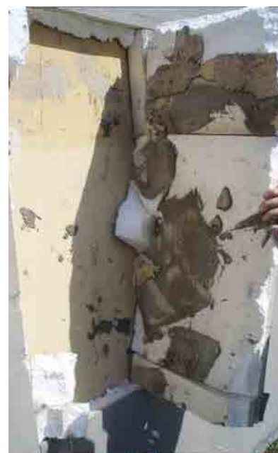
Odpadanie ocieplenia.
