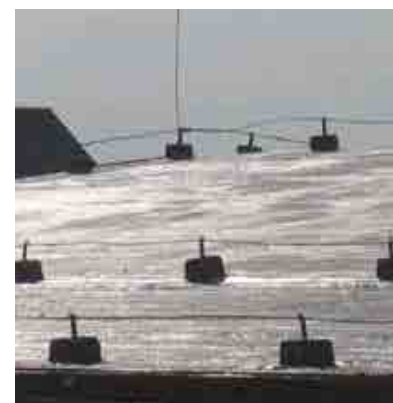
Zastosowanie emulsji bitumicznej odpornej na UV BOLIX B-MB Emulsion do naprawy starych pokryć dachowych.
