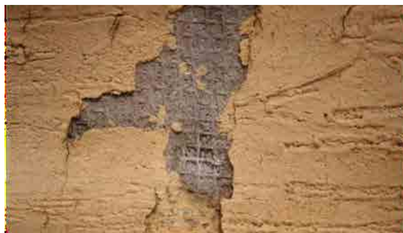
Utrata wytrzymałości warstwy zbrojącej.
