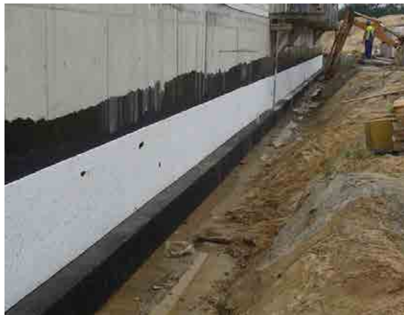
Zastosowanie mas grubowarstwowych do wykonywania izolacji i klejenia płyt izolacyjnych.
