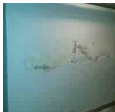
Powstawanie zawilgocenia skutkujące niszczeniem powłok dekoracyjnych
