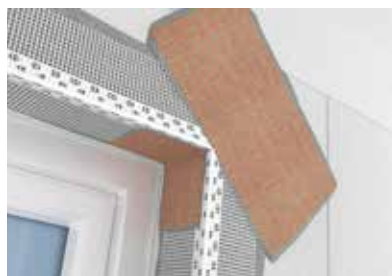
Wzmocnienie naroży stolarki okiennej.
