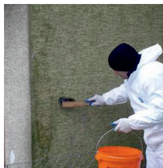
Nalóżenie roztworu preparatu BOLIX GLO
