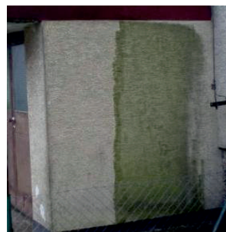
Lewa część ściany umyta preparatem Bolix Complex
