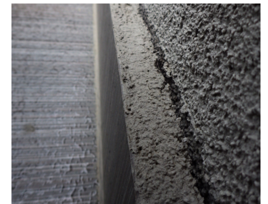
Rys. Cokolik na ścianie, brak uszczelnienia, szczeliny na połączeniu z tynkiem.
