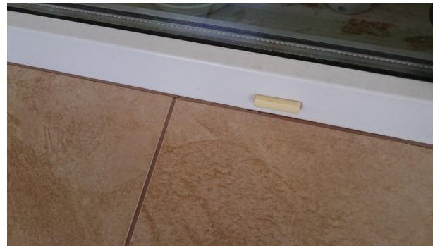
Fot. Połączenie okien/drzwi balkonowych z okładziną ceramiczną.
