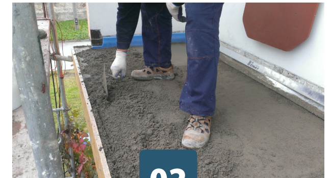
Warstwa spadkowa (posadzka zespolona z podłożem)
