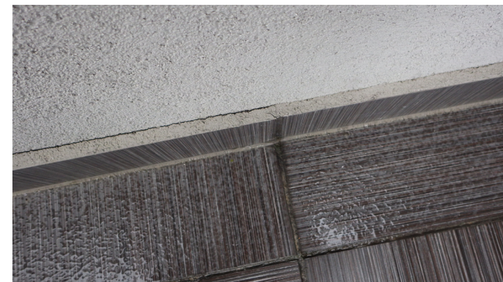
Rys. Cokolik na ścianie, brak uszczelnienia, szczeliny na połączeniu z tynkiem.
